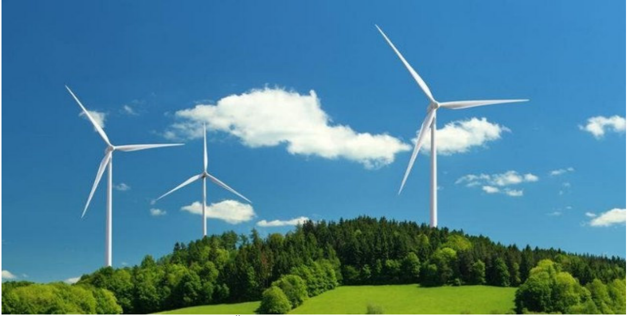
Şekil 3 : Örnek Rüzgâr Enerji Sistemleri
