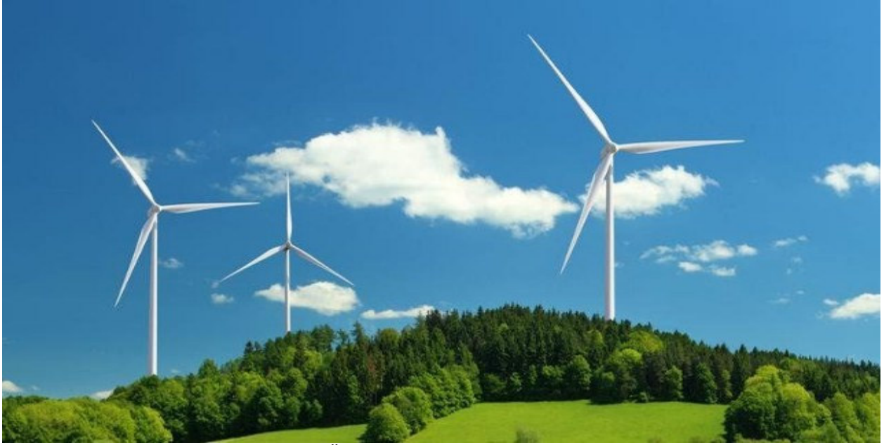
Şekil 3 : Örnek Rüzgâr Enerji Sistemleri
