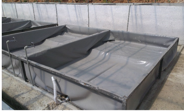
Şekil 3. İribaş yetiştirme havuzları
